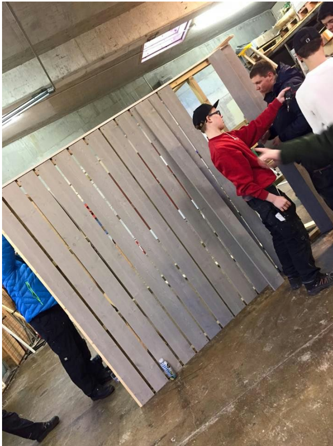
Levegg i matematikken, først bindingsverk, så montering av stående kledning.
